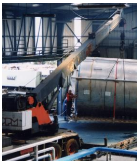
MISE EN PLACE CUVERIE 50M3
