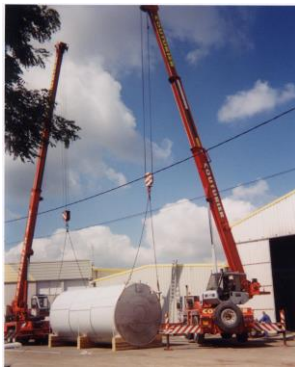
MISE EN PLACE CUVERIE REGION PARISIENNE
