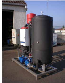
GRUPE FROID AVEC CUVE TAMPON ET EAU GLYCOLEE
