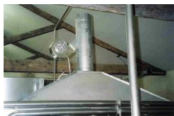
Hotte démontable pour la récupération et évacuation des vapeurs avec sortie diam 180 mm.
